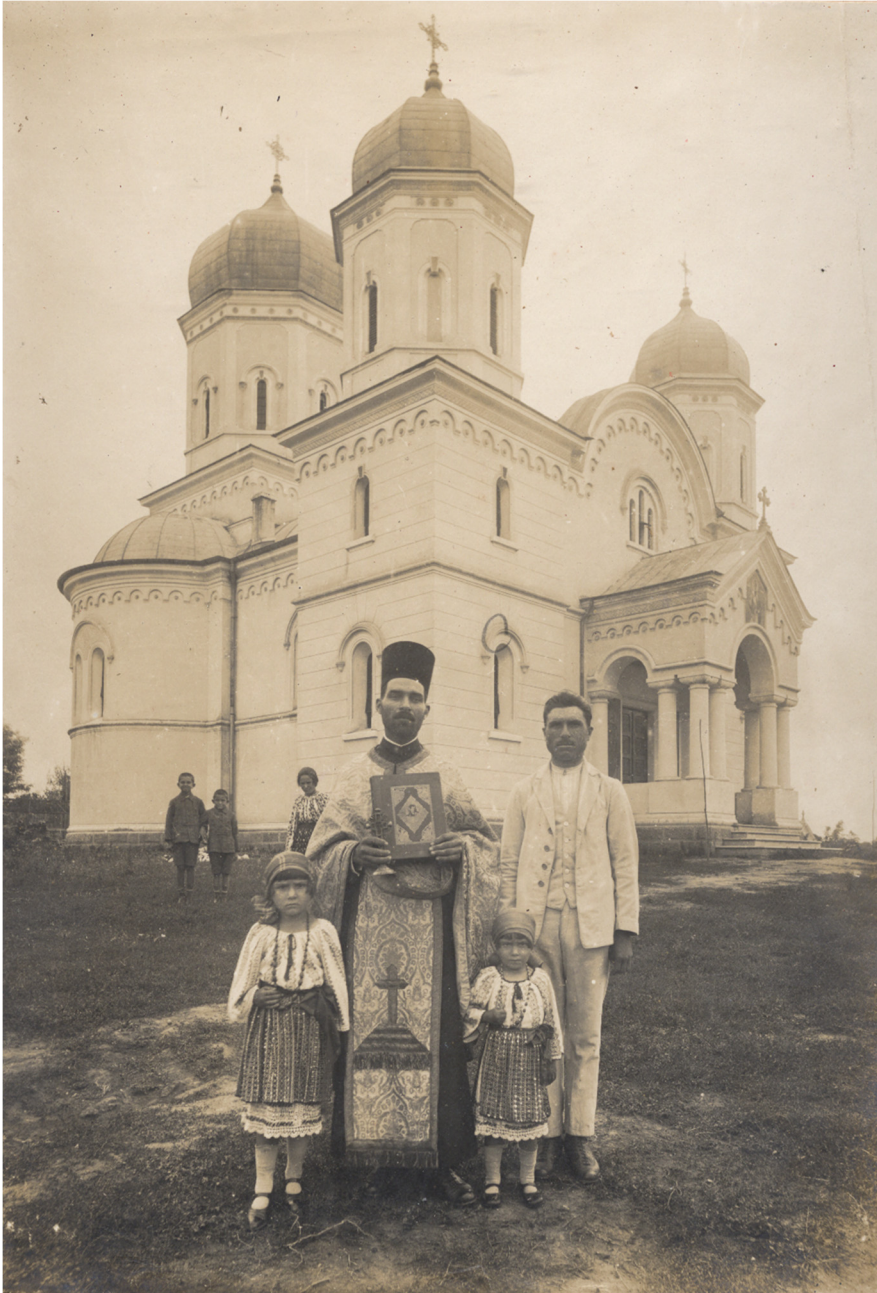
Fig. 20. La chiesa ortodossa Sfântul Nicolae eretta nel comune rurale di Moțaței (1911-1912) dal costruttore Pietro Adotti, in un'immagine d'epoca.
