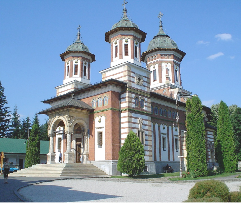
Fig. 12. Gheorghe Mandrea. Chiesa del monastero di Sinaia (1893-1903). Stato attuale.
