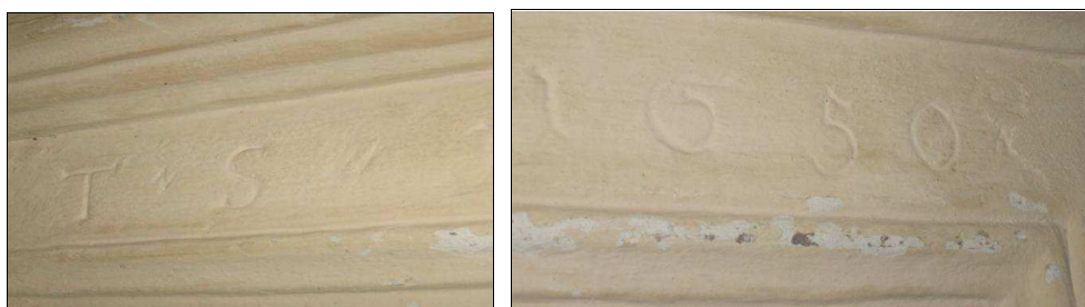
Fig.5. Detaliu – portal imobil strada Liviu Rebreanu nr. 1
