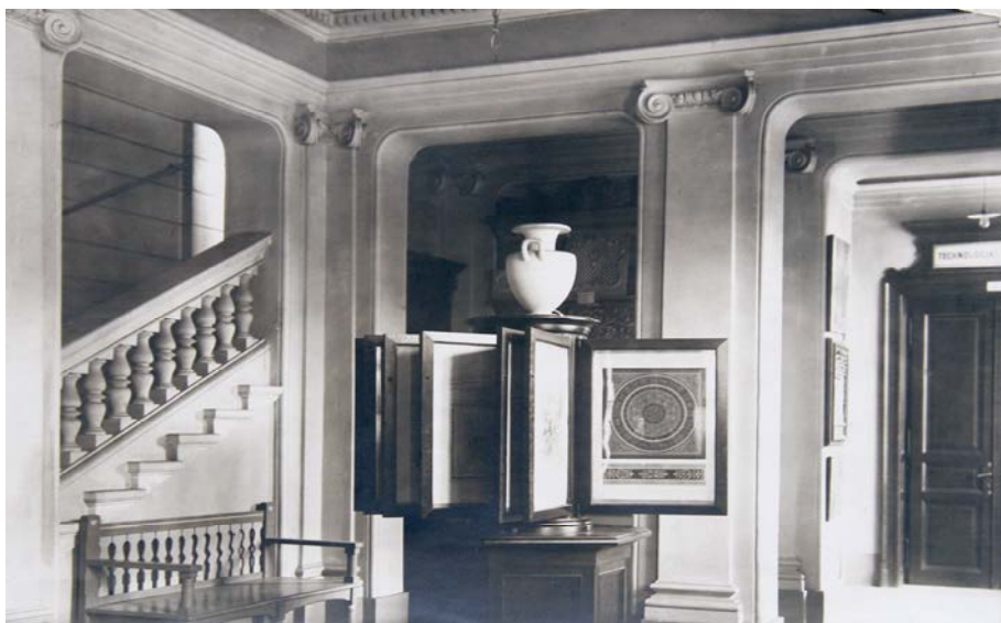
Fig. 8. Hala mecanică a muzeului și a școlii industriale, clădire proiectată de Lajos Pákei. s. a. ABUDC. Material Pákei, V-B-02. Reproducere: Lehel Molnár.
