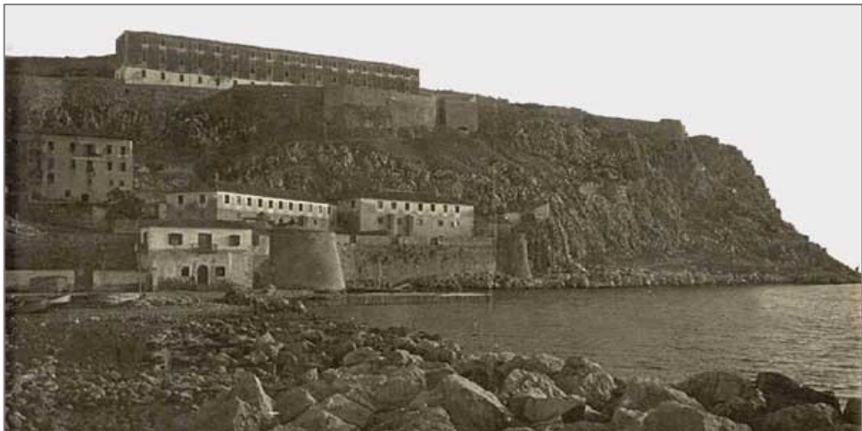
Fig. 4: The old Venetian building (now demolished) at the top of hill, housed the political prison of Acronafplia. Unknown photographer and date taken. Source: Αργολική Αρχαική Βιβλιοθήκη Ιστορίας και Πολιτισμού (The Argolikos Archival Library of History and Culture). Οι φυλακές της Ακροναυπλίας. | ΑΡΓΟΛΙΚΗ ΑΡΧΕΙΑΚΗ ΒΙΒΛΙΟΘΗΚΗ ΙΣΤΟΡΙΑΣ ΚΑΙ ΠΟΛΙΤΙΣΜΟΥ ( argolikivivliothiki.gr )
